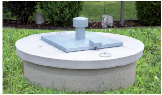
Brunnenvorschacht mit Schachtabdeckung und Entlüftungshut
