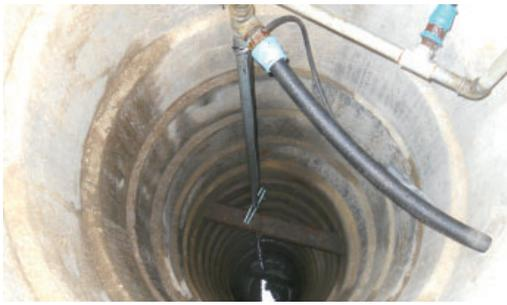
Mangelhafter Schachtbrunnen durch undichte Schachtringe
