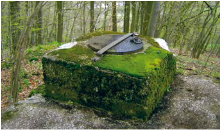
Bewuchs der Quelfassung
