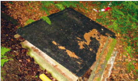
Unzureichende Abdeckung und provisorische bauliche Gestaltung einer Quelfassung
